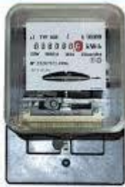
Licznik energii jednofazowy jednostrefowy 10/40A
